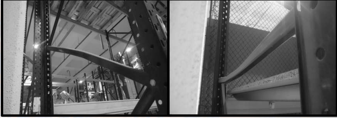
Çapraz Bağlantı Deforme
